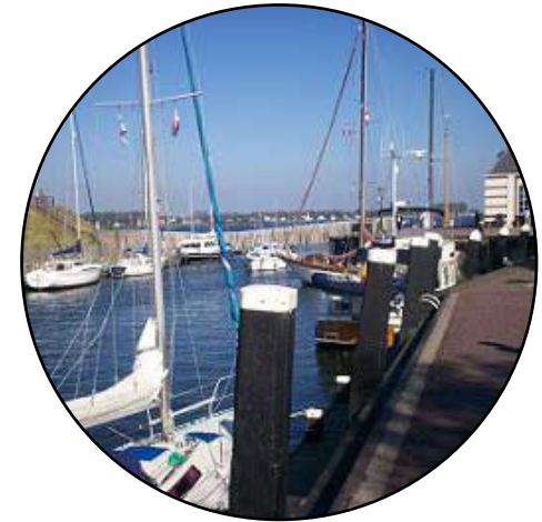
F Uitbreiding van het aantal ligplaatsen door de aanlegkade
